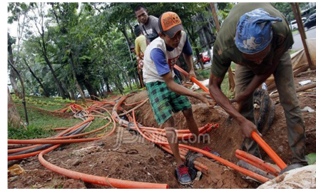
Gambar 4.1. Pemasangan instalasi listrik
