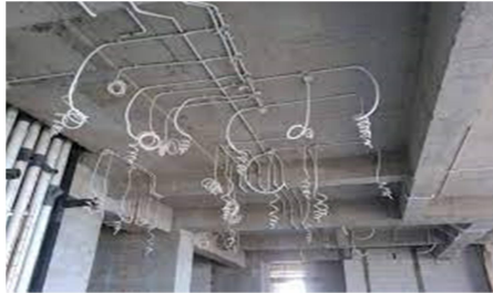
Gambar 4.1. Pemasangan instalasi listrik
