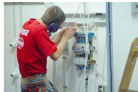
Gambar 4.2. Pemasangan Panel
